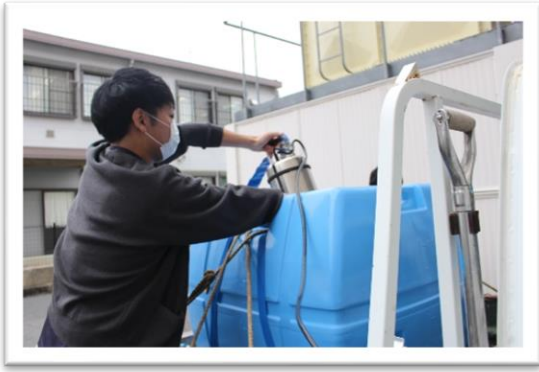
水中ポンプをタンクに入れる
