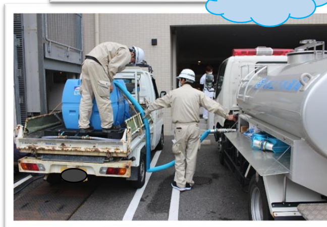
給水車からタンクに給水
