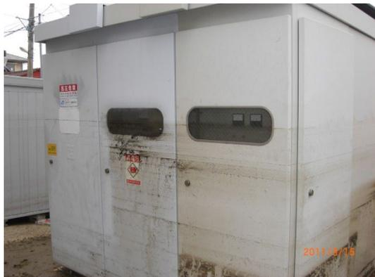
地域の電気は一週間程度で復旧しましたが、院内への電気の引き込みが出来ず、仮設キュービクル設置までの45日間を、震災前にリース契約していた小型発電機にて対応しました。
